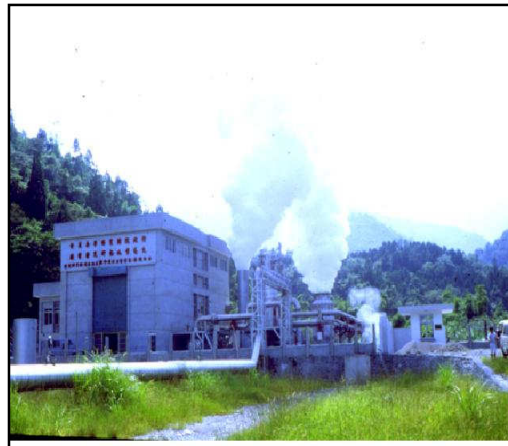
宜蘭清水先導型地熱發電廠 (3 MW, 已停產)
