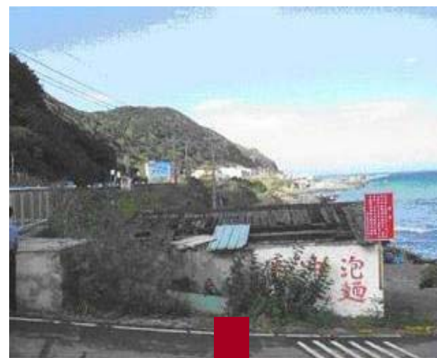
台2線違建拆除
